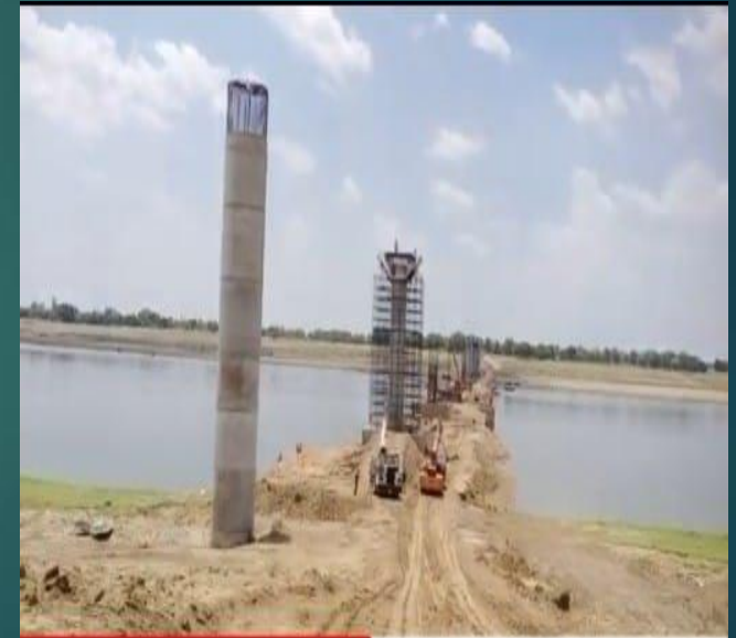
कौशांबी यमुना नदी New Bridge निर्माण कार्य I Kaushambi Bridge Uttar Pradesh I Yam...
